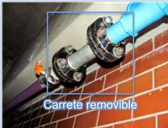
Además, por seguridad, se instaló un carrete removible que permite hacer una conexión provisional para irrigar agua potable otra vez a los sanitarios, en caso de que la PTAR sufra alguna descompostura y no pueda abastecerlos con agua tratada.
