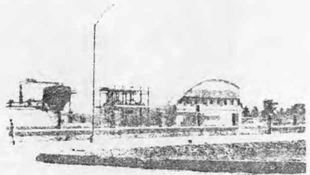
Vista de la subestación reductora de 20,000 a 4160 v y con capacidad de 9,200 kva. Al fondo la casa de máquinas para generar 6,000 kw.
