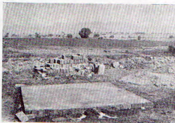
Losa de concreto armado para asiento del tanque
