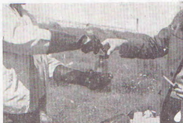
Agregado de almidón a una de las muestras para cerciorarse de que existe oxígeno disuelto
