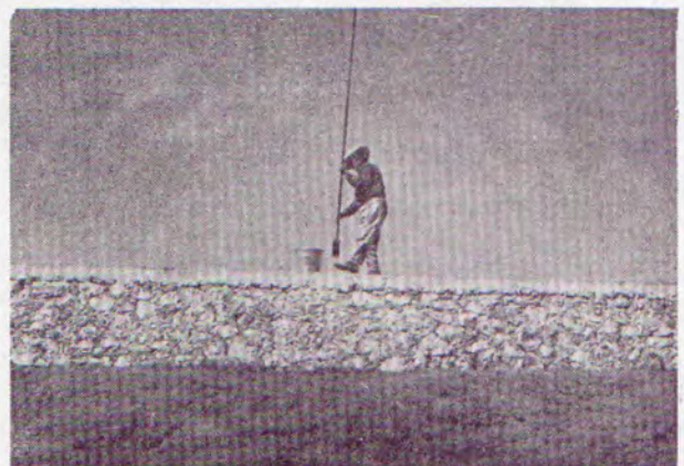
Toma de la muestra profunda en el tanque regulador "de mampostería"
