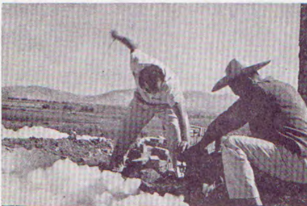
Llenado inicial del tanque con aguas negras tomadas de los canales de riego. Nótese la gran cantidad de espuma debida a detergentes
