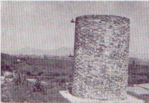
Tanque listo para su funcionamiento
