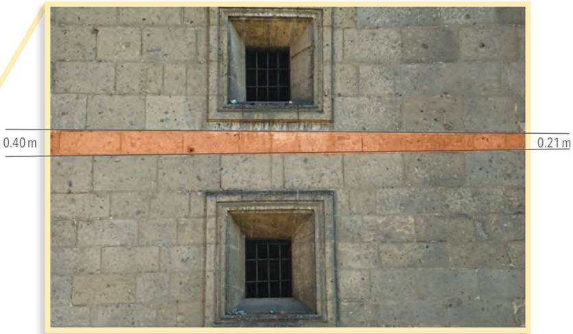
Rectificación de plomos con hilada de ajuste en la torre poniente. Se aprecia la diferencia de espesor de esa hilada para absorber los desniveles que se estaban produciendo en la estructura a causa de los hundimientos diferenciales.
