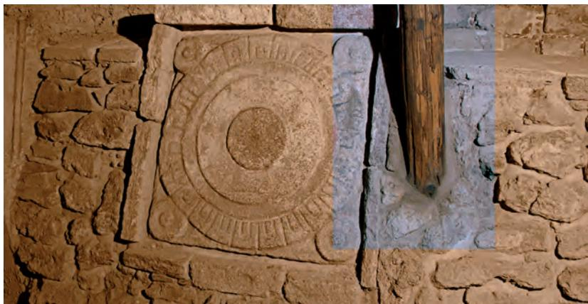
Pilotes de madera colocados al inicio de la construcción en la esquina oriente del Sagrario Metropolitano. Se puede observar que la punta se incrusta en una pared de la pirámide mexicana.
