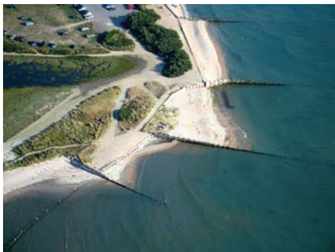
Figura 4: Campo de espigones para la protección costera
