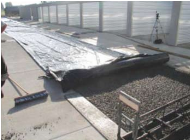
Material de polietileno utilizado para cubrir la superficie expuesta del concreto permeable (Tennis et al. , 2004).
