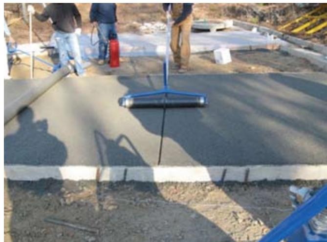
Cimbra de madera sujeta a base de clavijas. ( http://curbspecialists.com/images/gallery/Pervious%20Concrete%205.jpg ).
