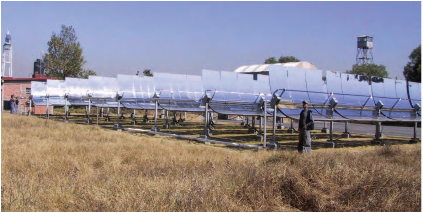
Planta solar del Instituto de Ingeniería
