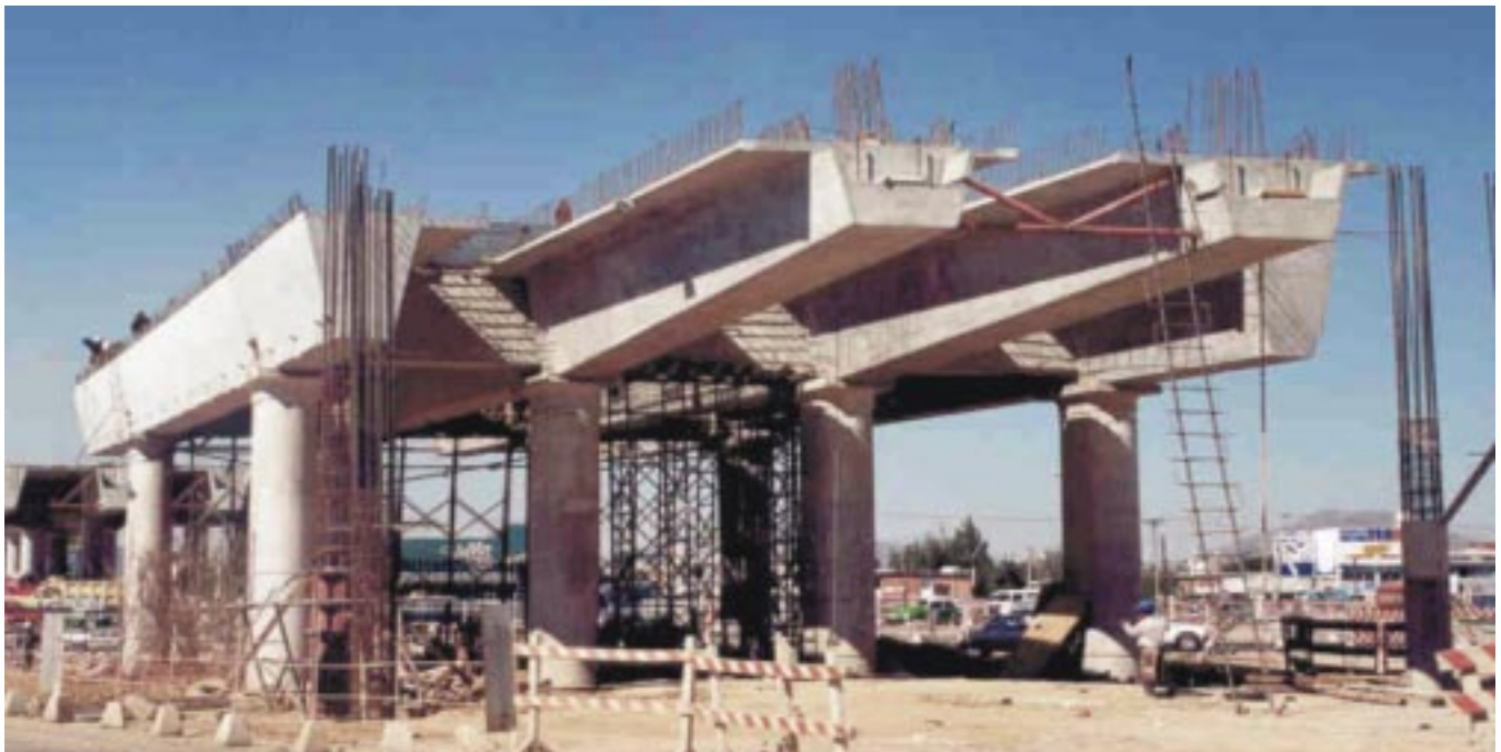
Puente Impulsora cuya cimentación fue instrumentada
