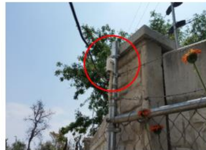
b) GPS colocado sobre mástil
