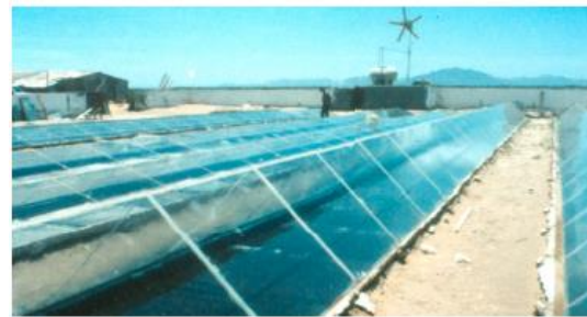
Figura 3. Destilador solar de gran dimensión para abasto de una comunidad rural (en Puerto Chale, Baja California Sur)
